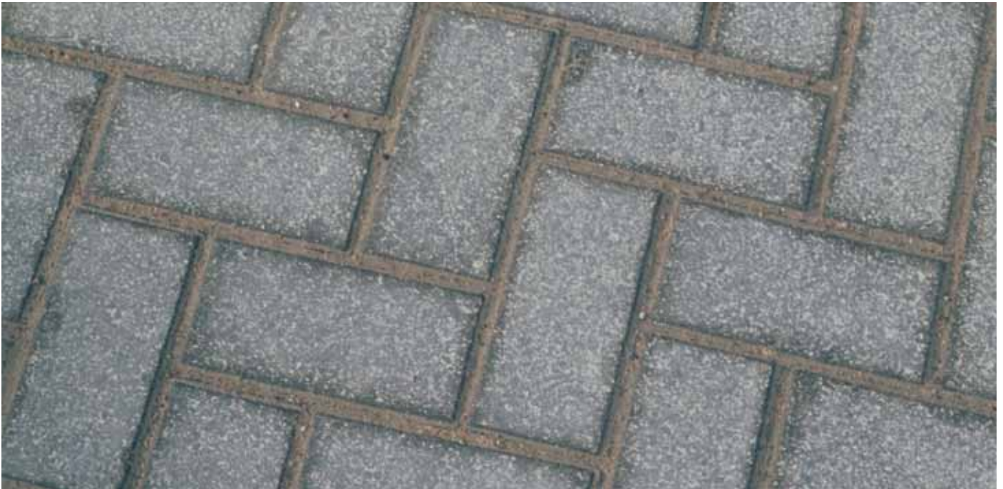
En välfylld fog hindrar ogräs och ger en stabil beläggning som tål påfrestningar.
